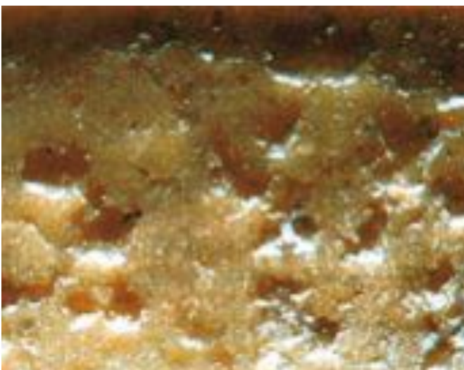
Bild 11: Erosionsschäden durch zu glatte Wellen
